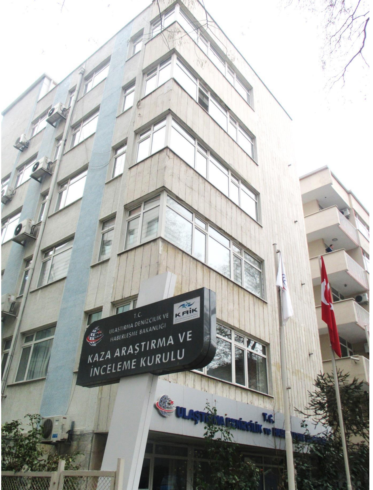
Resim 1 : Kaza Araştırma ve İnceleme Kurulu Yerleşkesi
