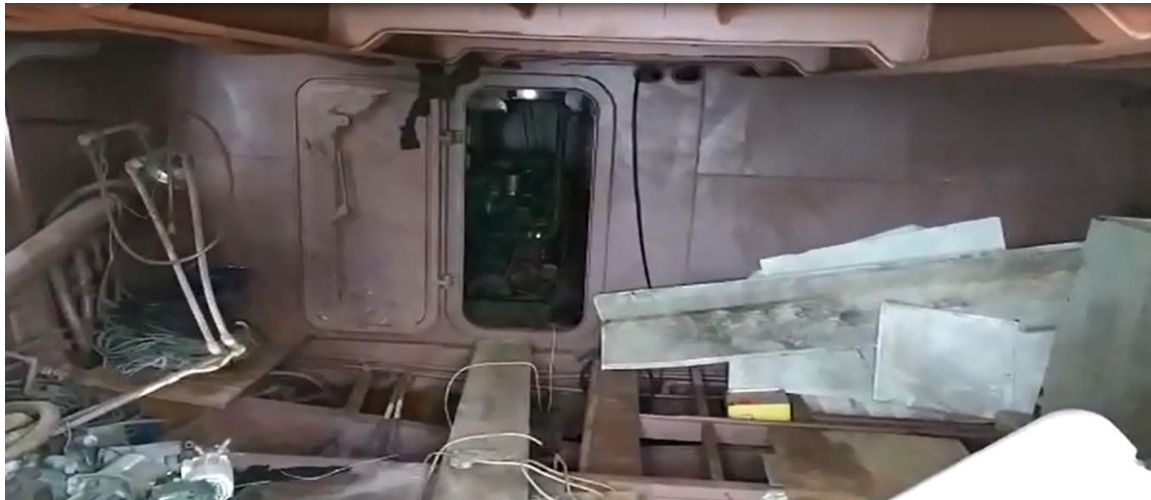
Resim 7: Makine Dairesine Giriş Kapısı.
