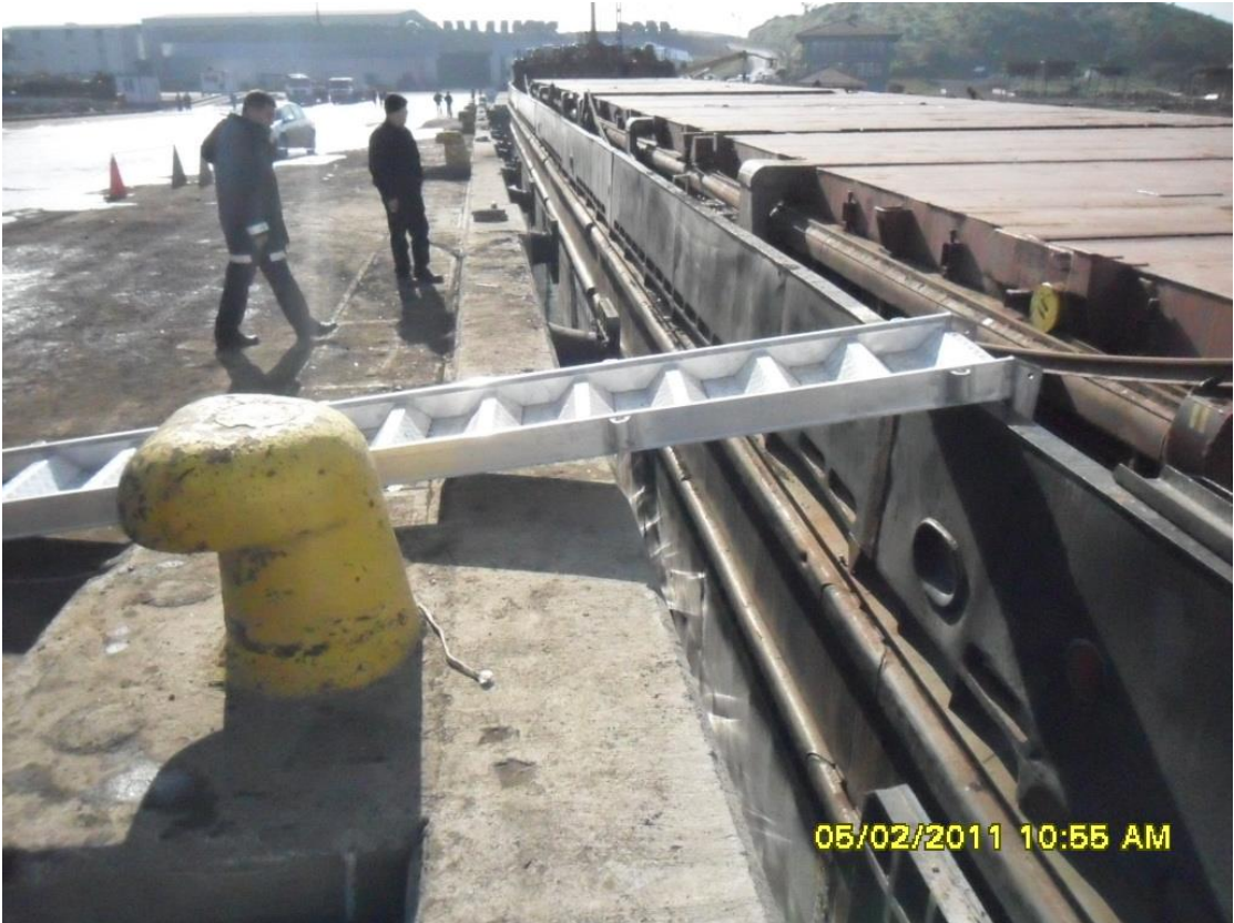
Resim 11: Sürme iskele pozisyonu
