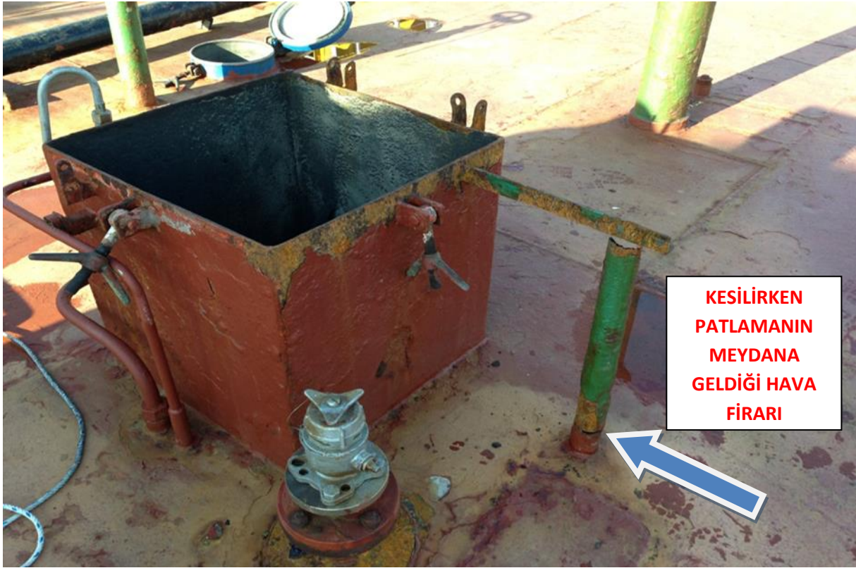
Resim 4 : No.2 Sancak Yan Tank Koferdam Giriş Menholü
