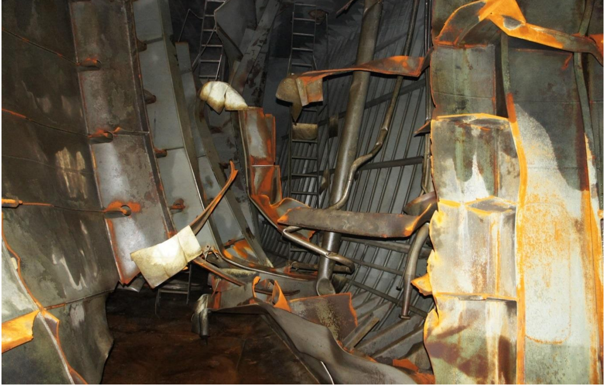
Resim 6 : No.2 Sancak Yan Tank Hasarı
