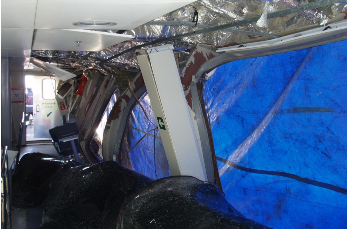
Resim 17: SULTANAHMET Gemisi Ara Güvertede Hasar
