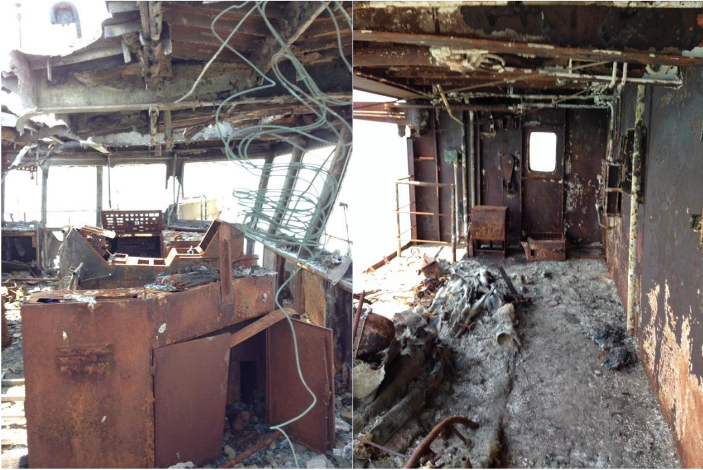
Şekil 6. Yangın sonrası köprüüstü ve yaşam mahali
