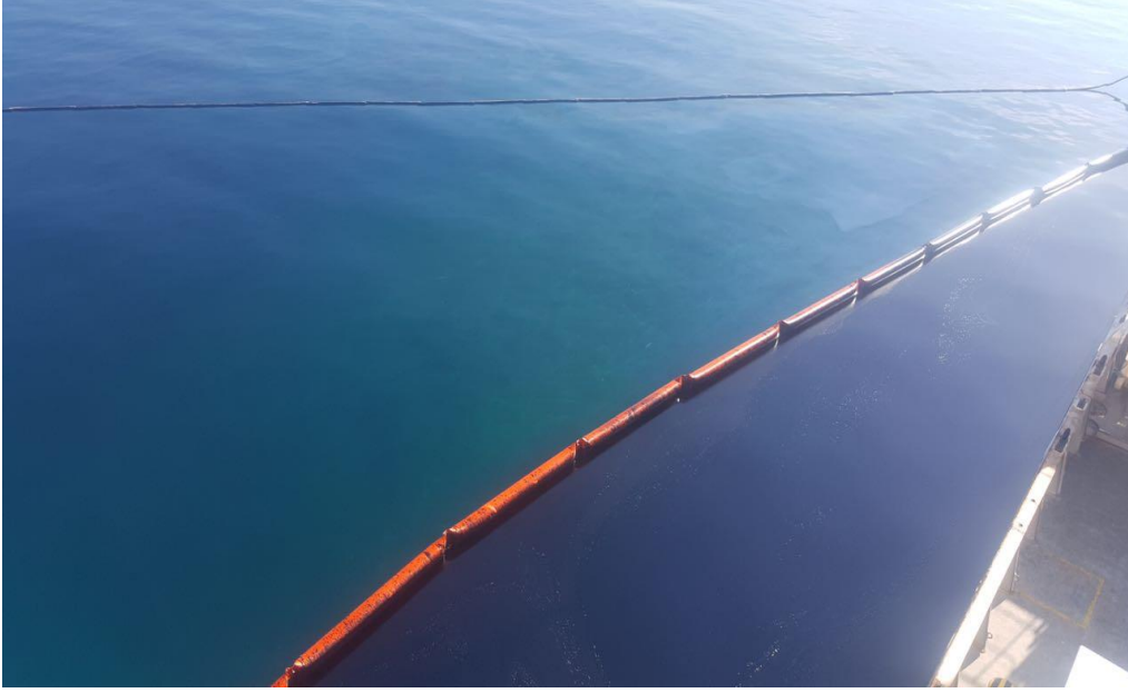
Resim 10: Gemiden Sızan Yakıtın Bariyerlerce Çevrilmesi
