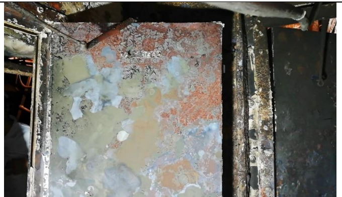
Resim 18: Makine Dairesi Giriş Kapısının İç Yüzeyi
