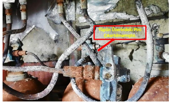
Resim 34: Patlatılamayan CO 2 Tüpü
