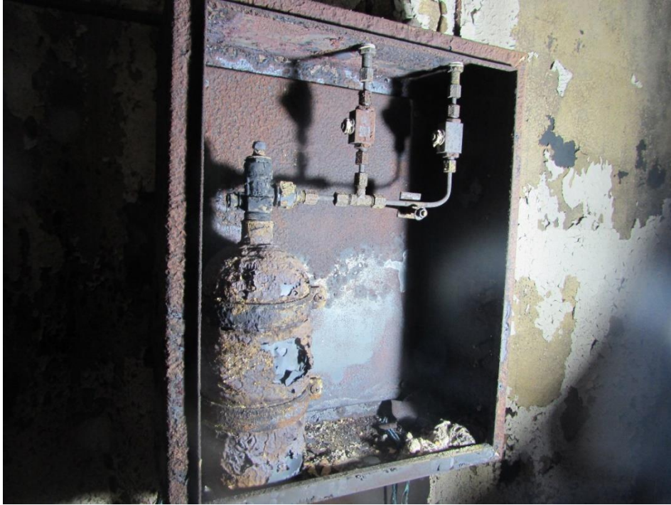
Resim 35: CO 2 Uzaktan Patlatma Ünitesi
