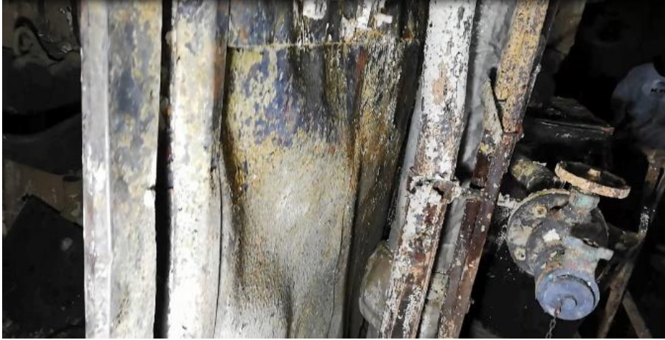
Resim 21: Kazanın Bitişigindeki Saç Perdenin Deformasyonu
