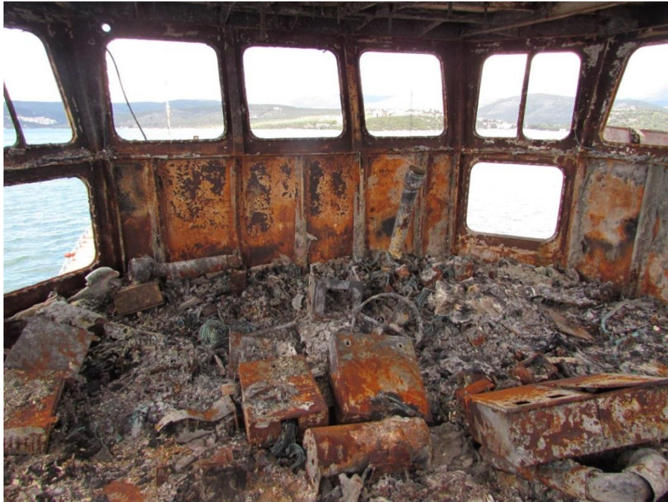
Resim 11: Yangın Sonrası Köprü Üstünde Meydana Gelen Hasar
