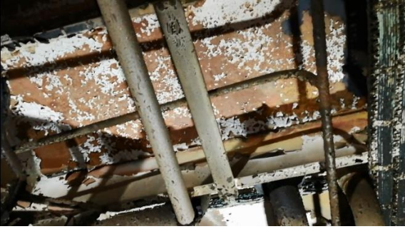
Resim 31: Makine Dairesi Zemin Katı Tavan Boyası
