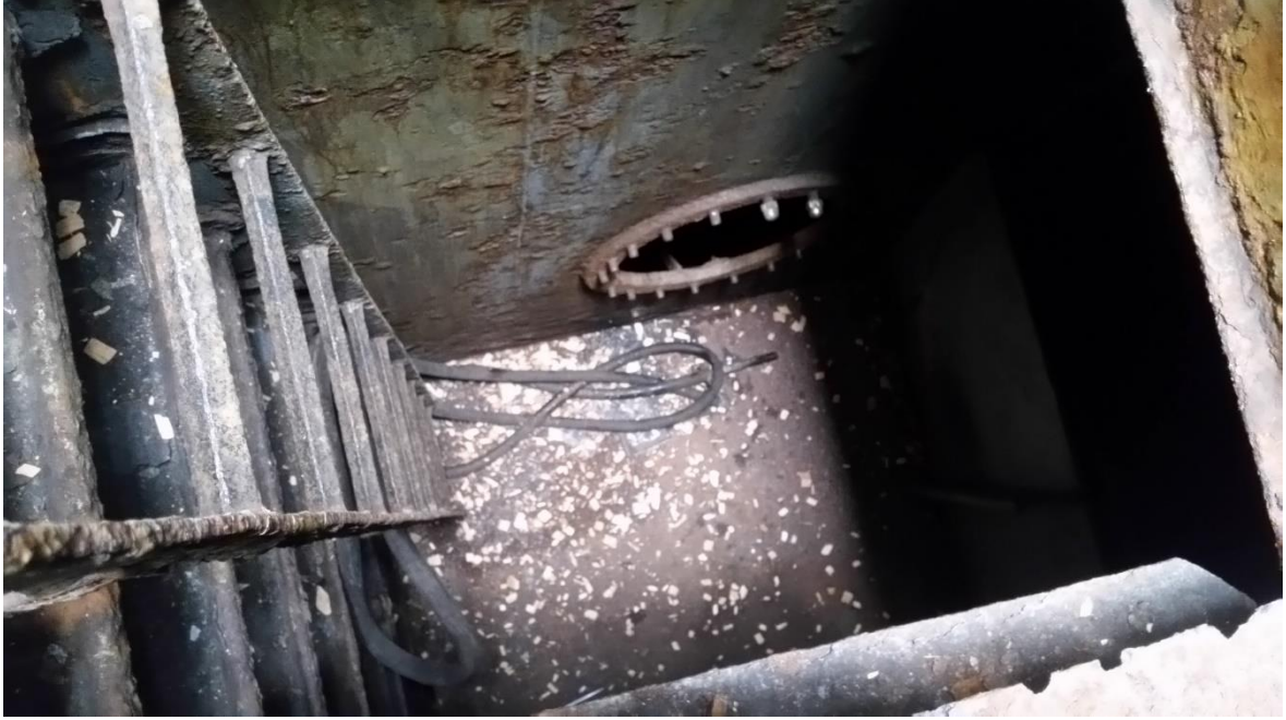
Resim 7: 4.11 Nolu Asma Tankın Açık Bırakılan Menhol Girişi
