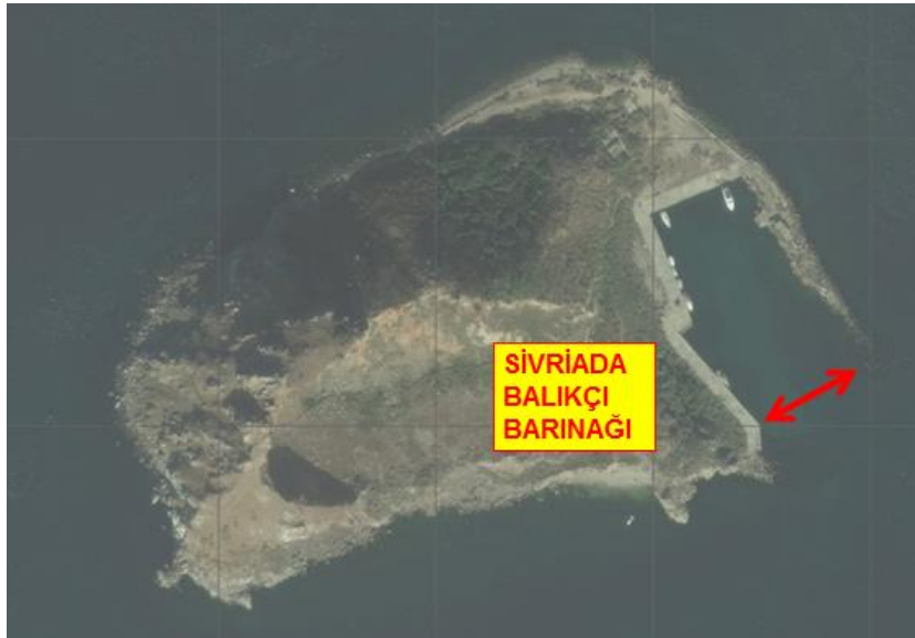
Resim 18: Sivriada Balıkçı Barınağının Girişi
