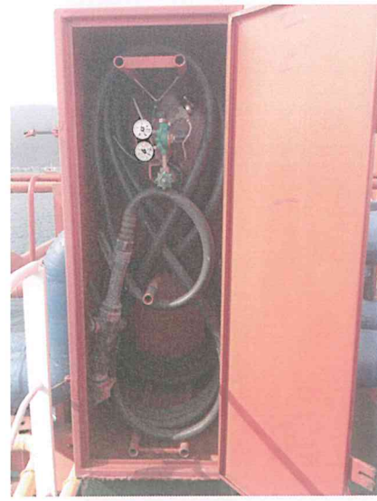
Resim 24,25: Sabit Kuru Kimyasal Toz Yangın Söndürücü Sistemi
