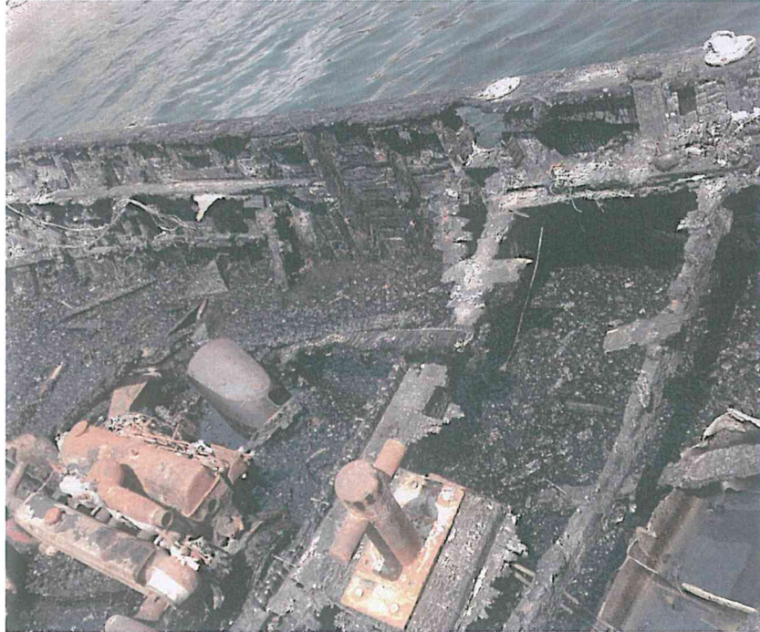
Resim 11:Yangın Sonrası SERDAR 2 İsimli Acente Botunda Oluşan Hasar
