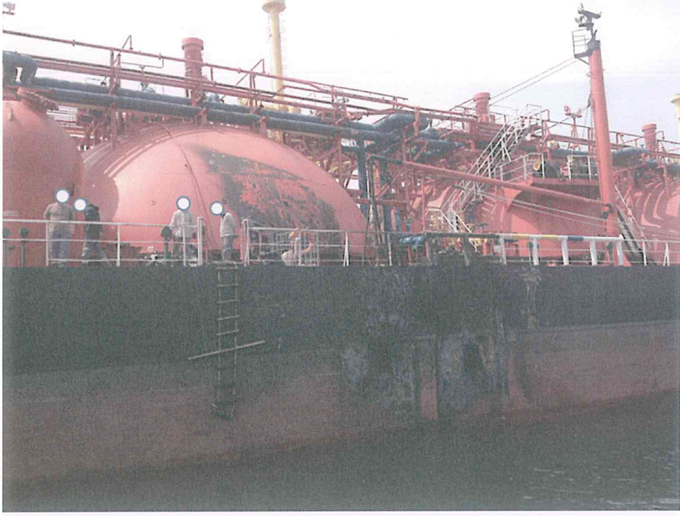
Resim 4: HABAŞ Gemisinde Meydana Gelen Yangın Hasarı.
