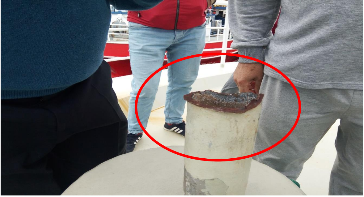
Resim16: Kopan babadaki kulakçığındaki zamanla meydana gelen korozyon.
