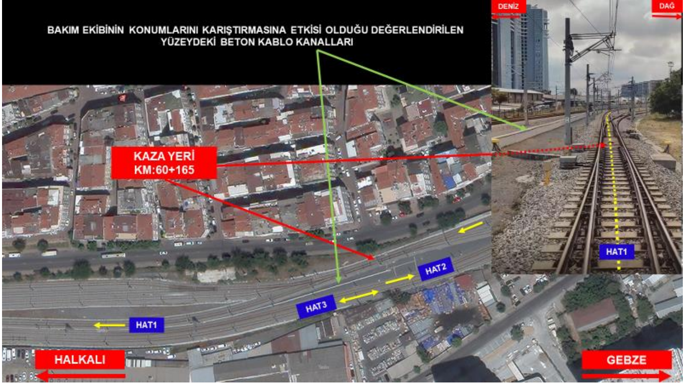
Şekil 18 Kaza Yeri Beton Kablo Kanalları
