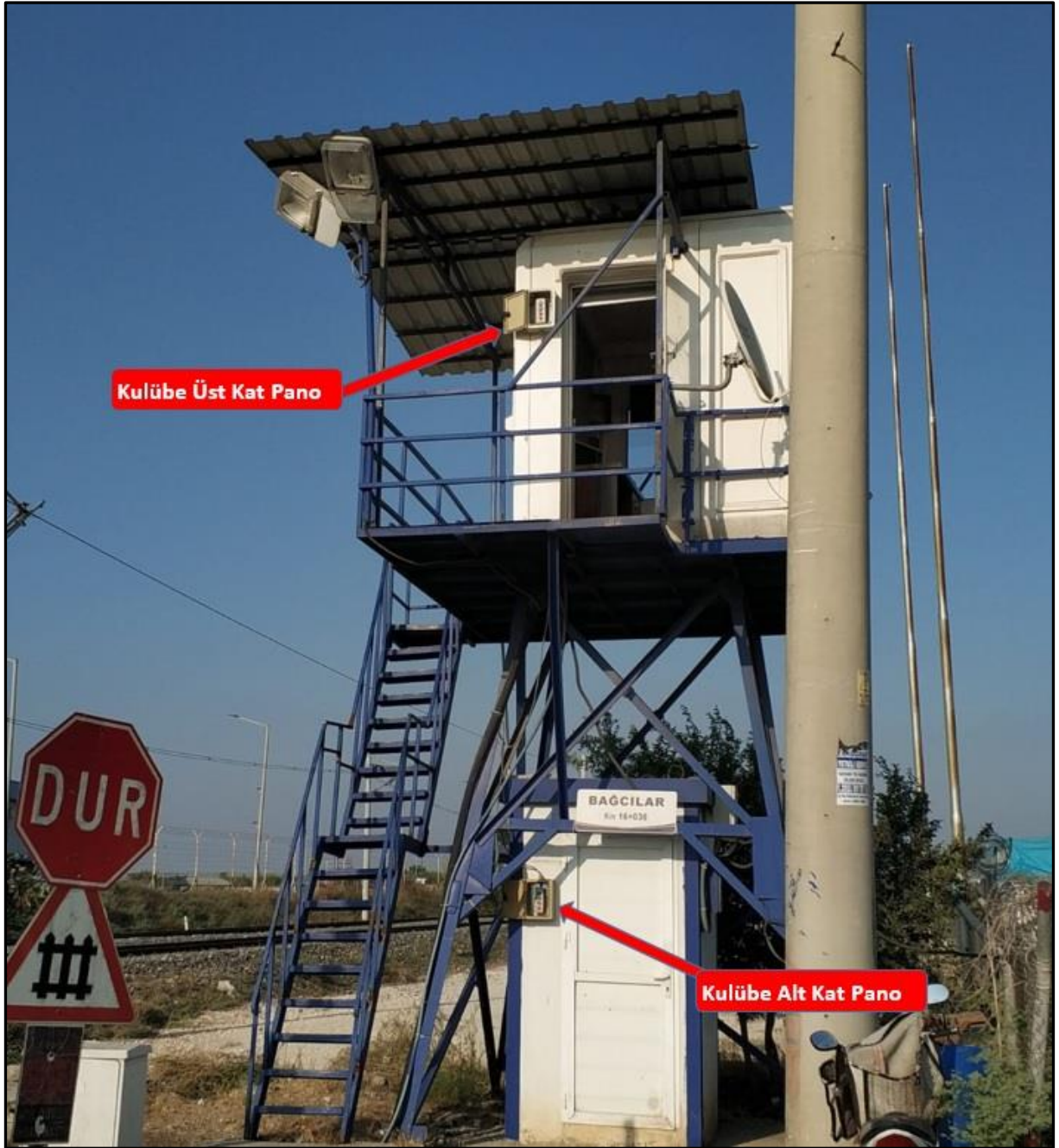
Resim 13 (Bağcılar Hemzemin Geçit Bekçi Kulübesi)
