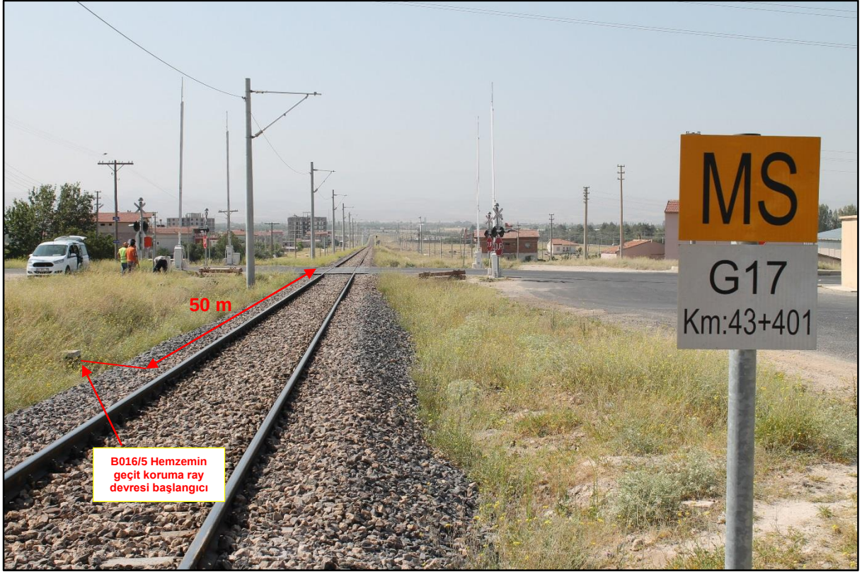
Resim 9: (23420 numaralı trenin geldiği yönden G17 hemzemin geçit koruma ray devresi başlangıcı-B016/5)
