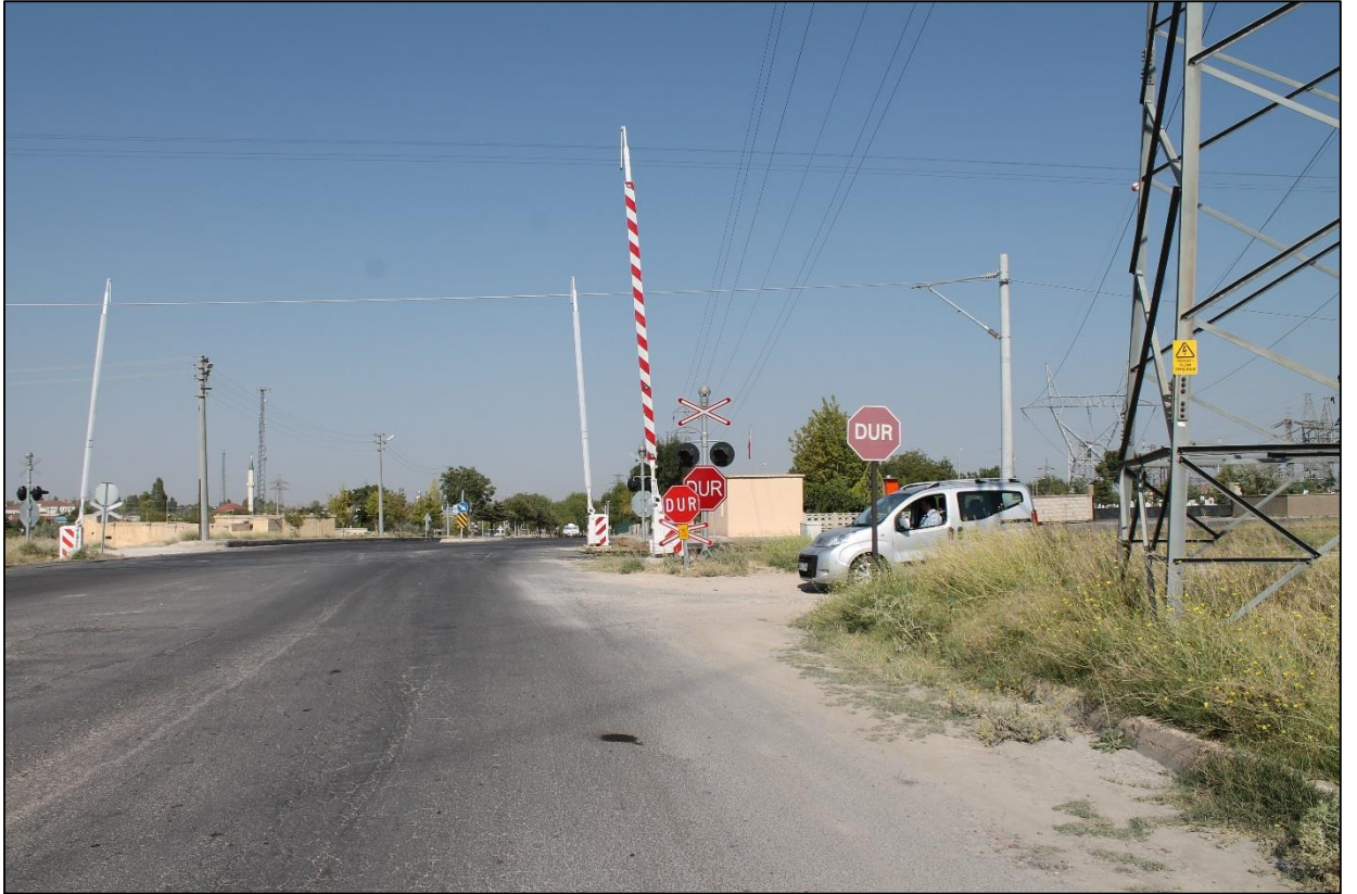
Resim 29 : (Yaklaşma yoluna direk bağlanan servis yolu)
