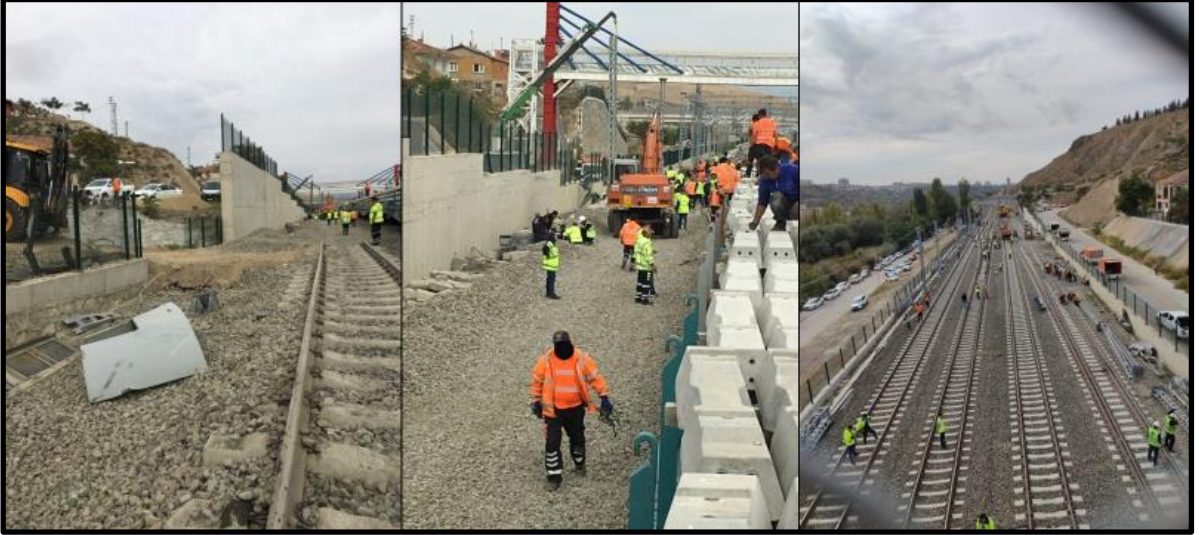
Şekil 15 Hat-1 Yol Tamir Çalışmaları
