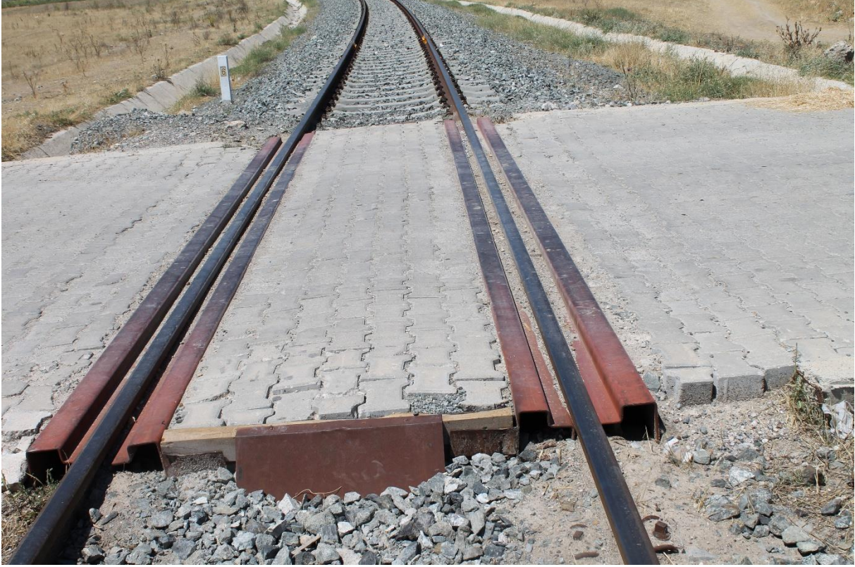
Resim 5 (Hemzemin Geçit Kaplaması)
