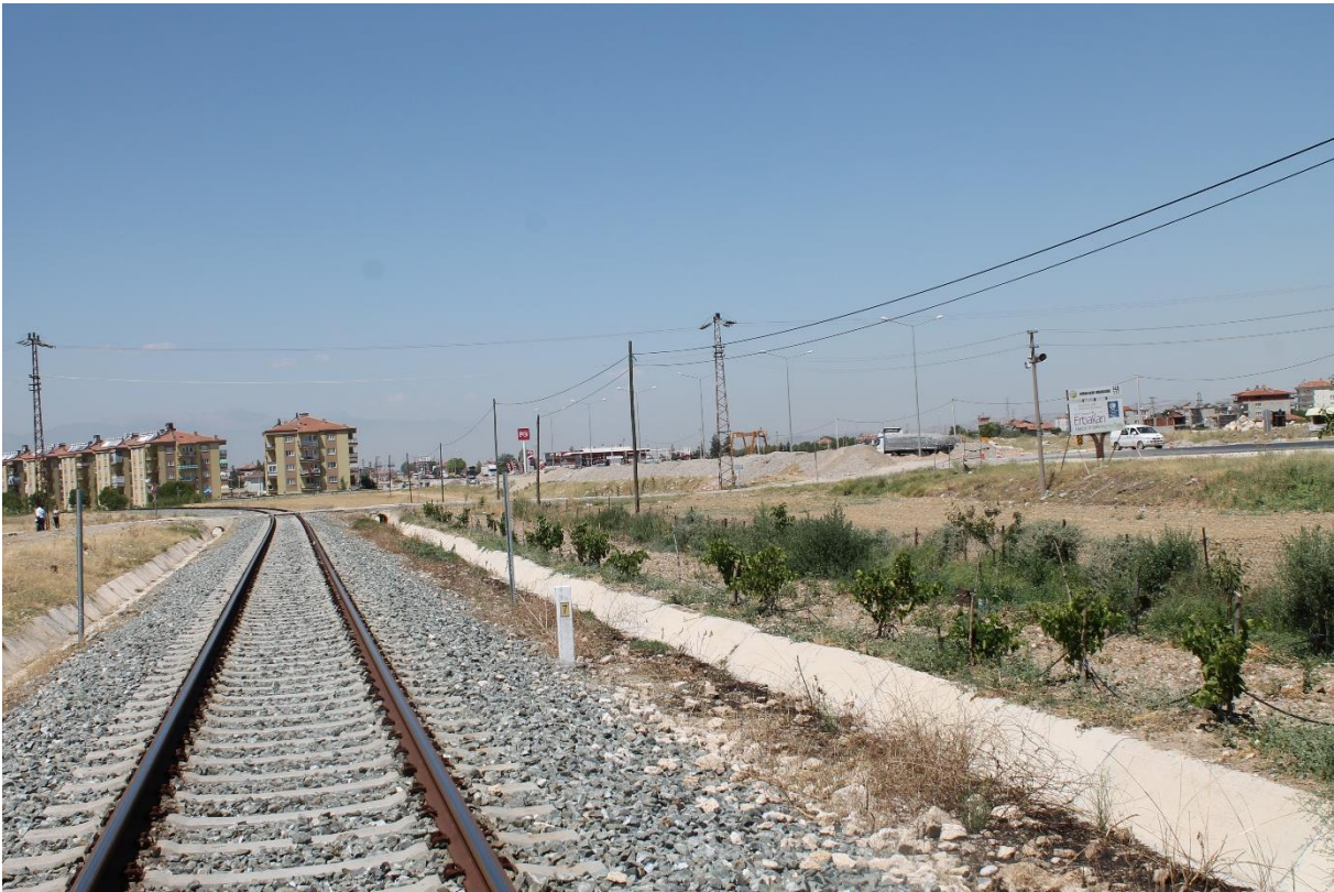
Resim 9 (Denizli-Ankara Devlet Yolundan Kaklık Mahallesine Bağlantı Yolu ve Hemzemin Geçit)
