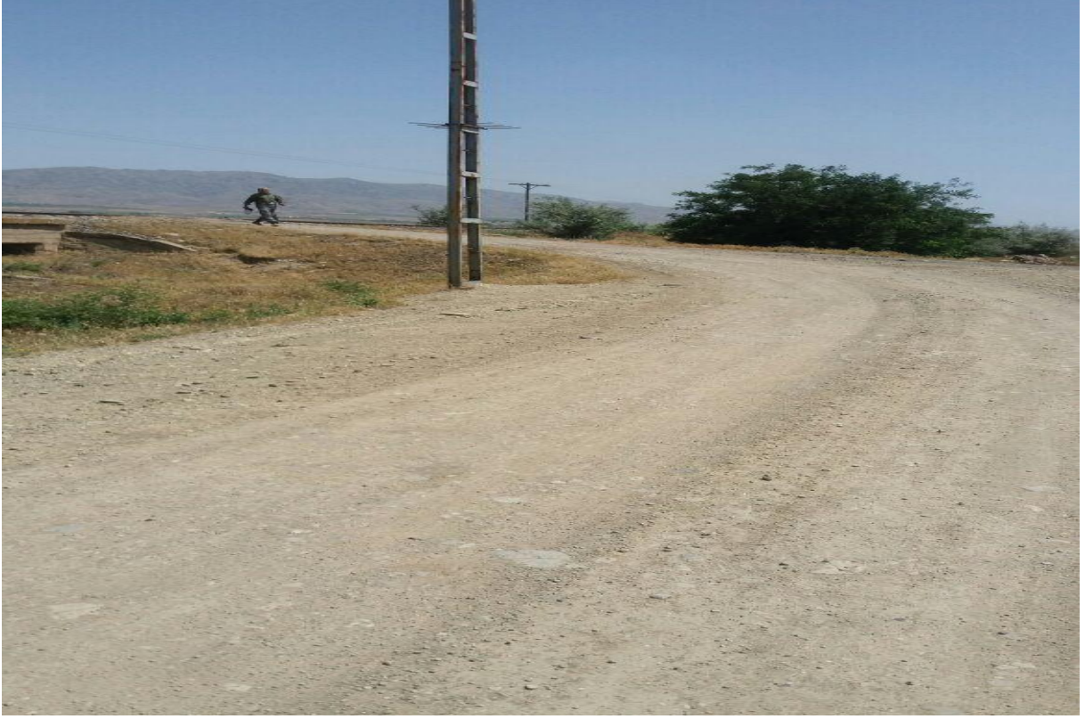
Resim 12 (İzinsiz Geçiş Yapılmaya Çalışılan Demiryolu Hattı Yaklaşım Yoluna Ait Görüntü)
