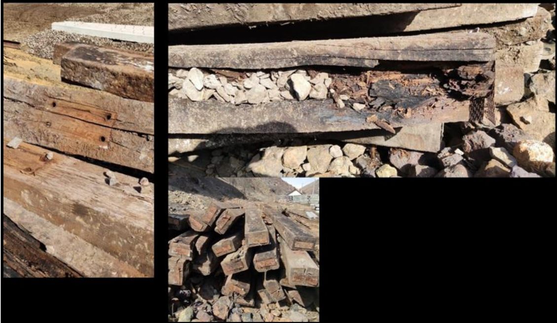
Şekil 9 Kazadan Sonra Sökülen 06D Makasa Ait Traversler
