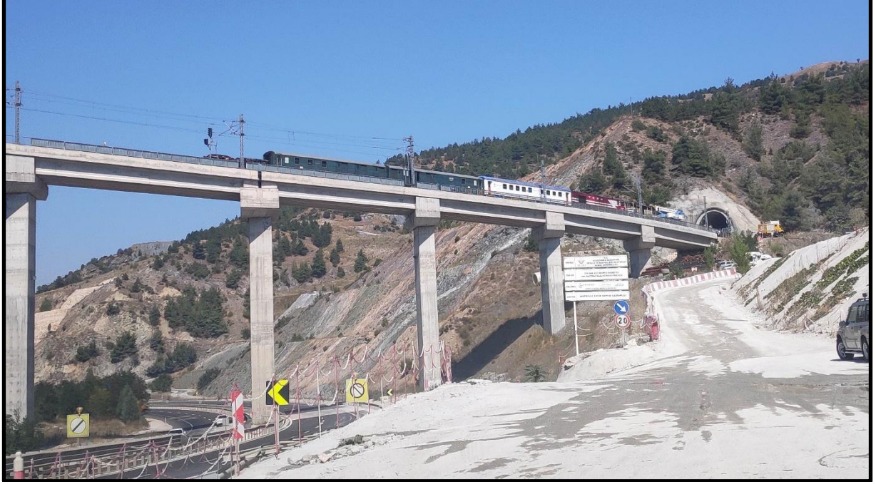
Resim 12 (Bypass Tüneli Doğu Girişi ve Viyadük)
