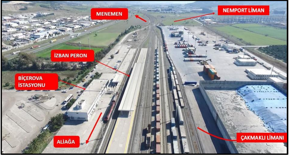
Resim 8 (Biçerova İstasyonu Drone Görüntüsü)
