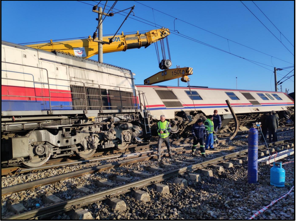
Resim 6 (Lokomotif ve jeneratör vagonunun deray kaldırma çalışmaları)
