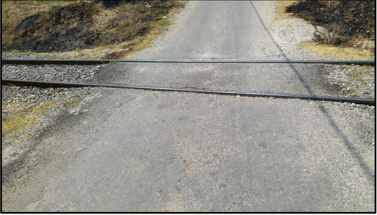
Resim 8 (Hemzemin Geçit Kaplaması)
