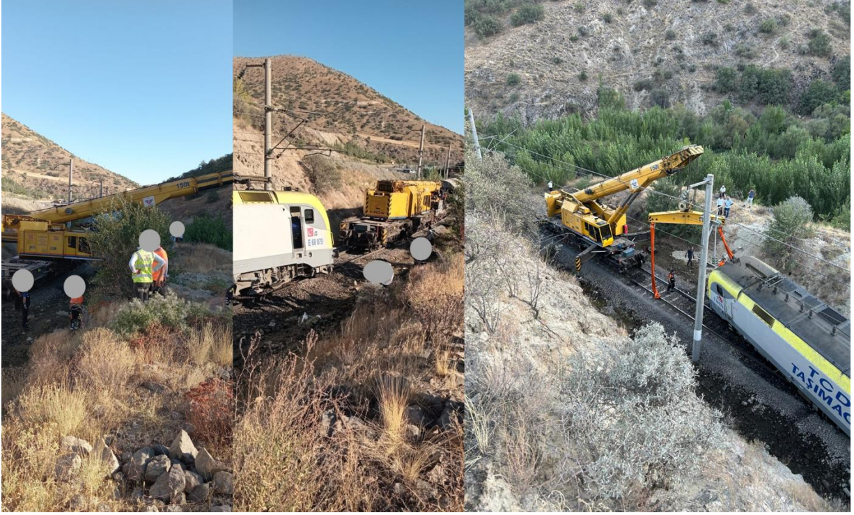
Şekil 5 Deray kaldırma çalışmaları
