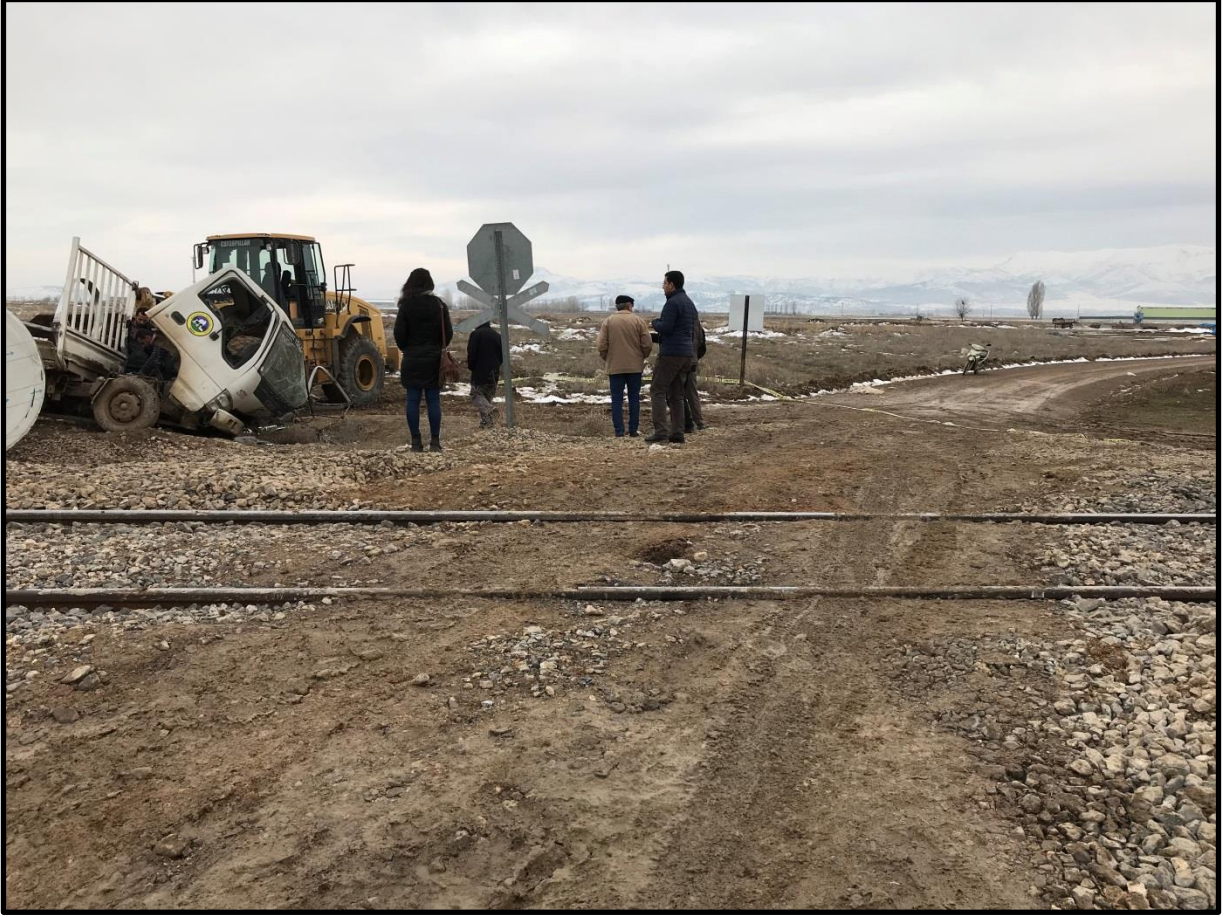
Resim 12 (Stabilize malzeme kaplama)
