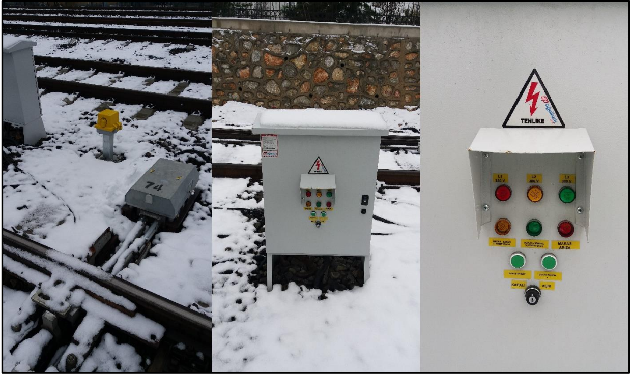
Resim 14: (M74 Makas motoru ve kumanda panosu)
