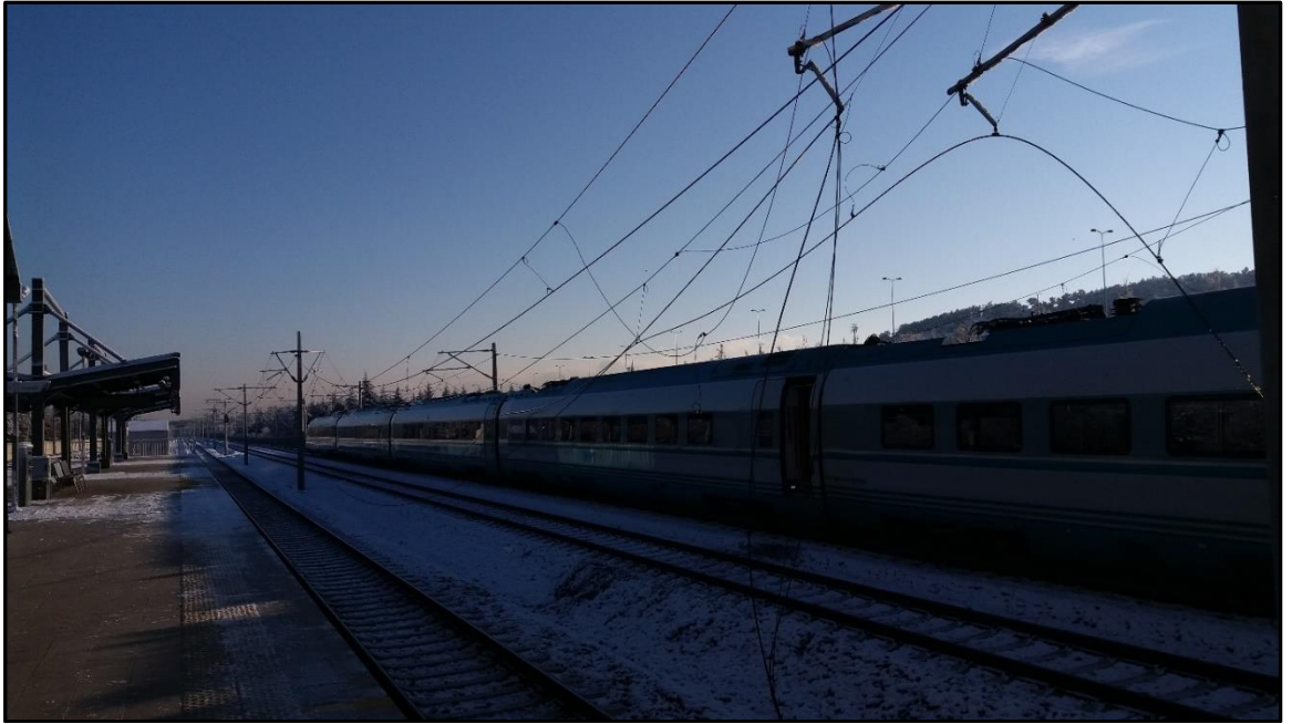
Resim 18 : (Kaza sonrası YHT setinin arkası ve elektrifikasyon tesislerinin durumu)
